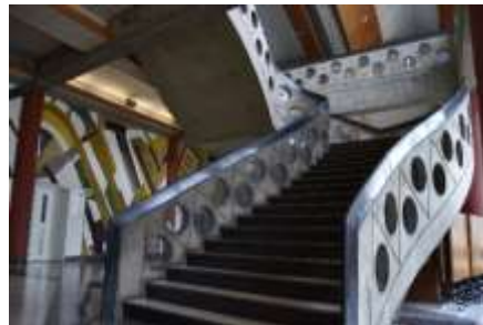
支柱のない階段
